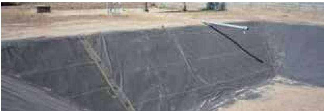
Photo 55: Effluent inlet pipe
